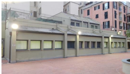
Figura 4.2 – Facciata esterna – Vista posteriore
