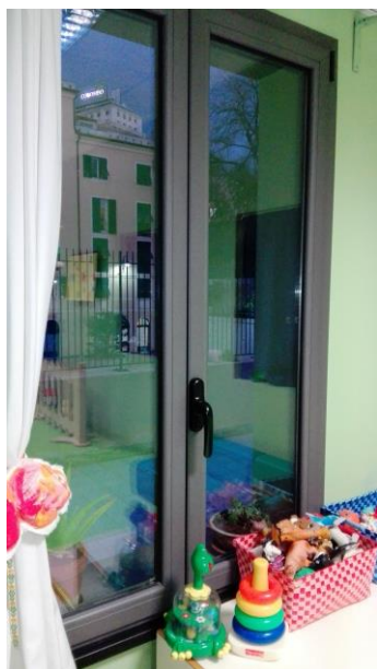
Figura 4.6 – Serramenti in alluminio e vetrocamera
