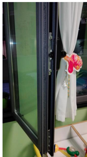
Figura 4.7 - Serramenti in alluminio e vetrocamera - particolare
